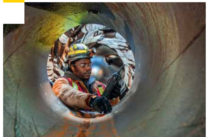
Проверка оборудования на нашем объекте Albian Sands в Канаде
